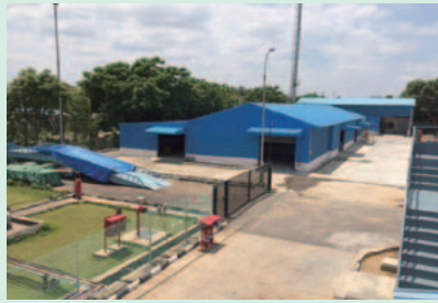
新倉庫建設中(完成間際)
