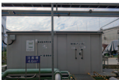
環境監視測定室
