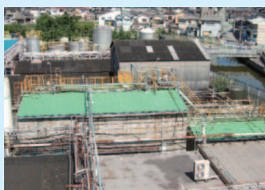
プロセス廃水貯留槽
