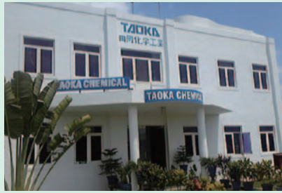
タオカケミカル インド工場および事務所
