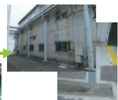
雨水対策 (排水溝の変更)
