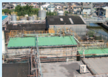
プロセス廃水貯留槽
