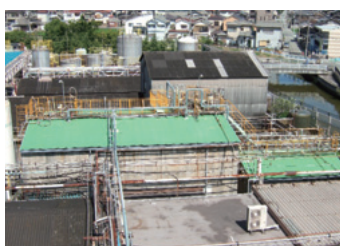
プロセス废水貯留槽
