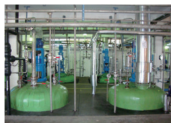
増設蒸留設備(前2つ)
