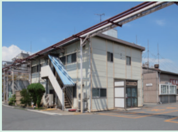
田岡播磨ジェネラルサービス株式会社事務所（全景）（正面）
