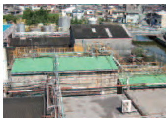
プロセス廃水貯留槽
