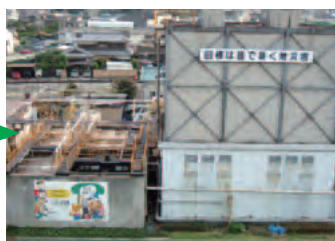
生物活性法廃水処理設備
