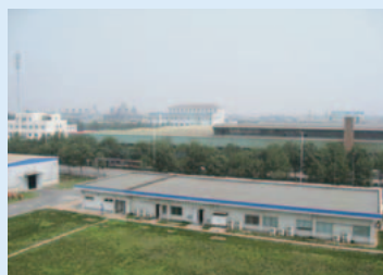
工場屋上より北側望む 手前は事務所
