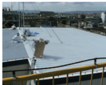
工場屋根(遮熱塗装)
