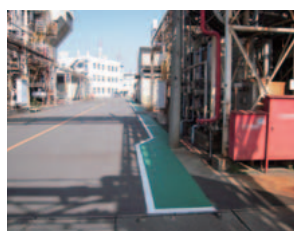
構内歩道を区別し歩行者の安全を確保
