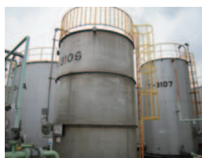
タンクに背カゴを取り付け 安全性を強化
