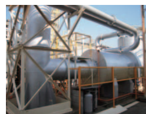
環境整備(汚泥焼却炉塗装)
