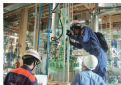
消防完成検査
