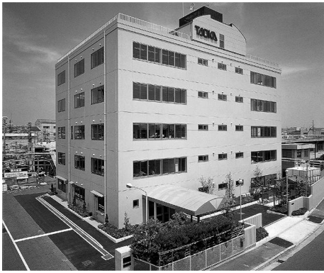
事務研究棟（大阪市淀川区）
